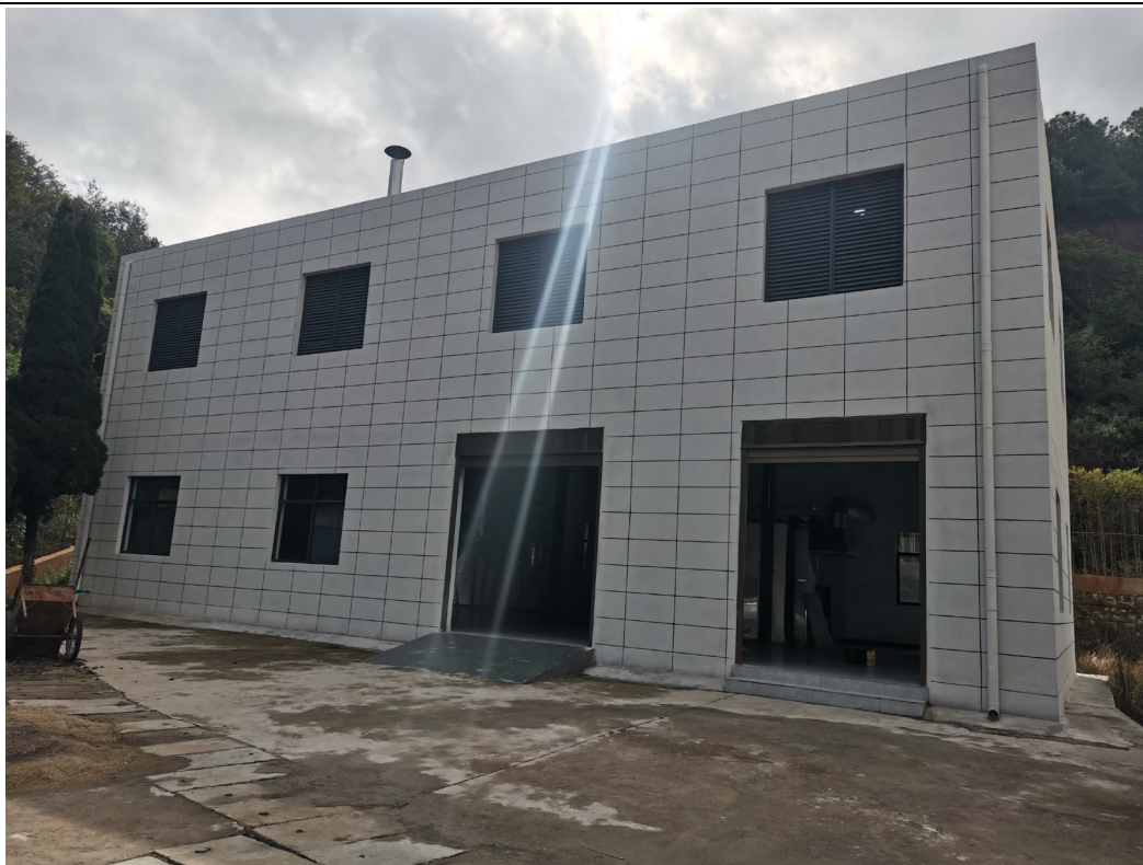
新增遗物焚烧炉车间及排气筒
