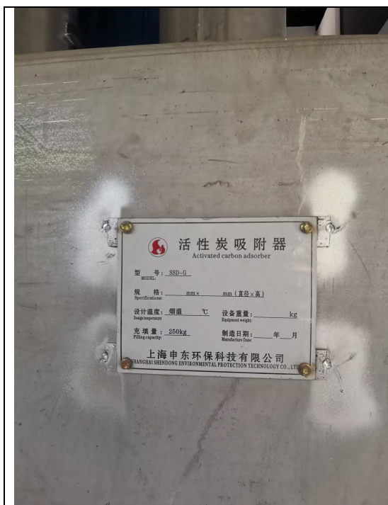
提升改造火化废气处理设施（活性炭吸附）
