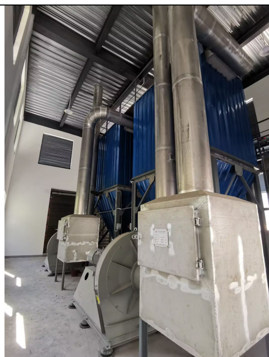
提升改造火化废气处理设施
