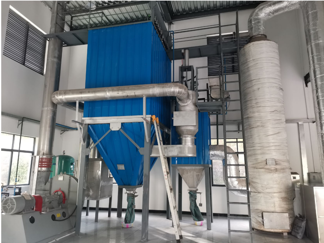
遗物焚烧炉废气处理设施
