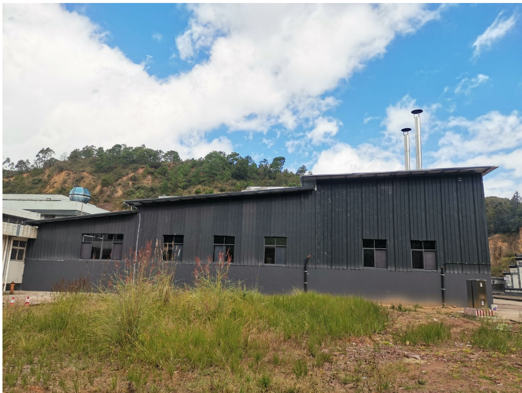
新增火化设备车间及排气筒
