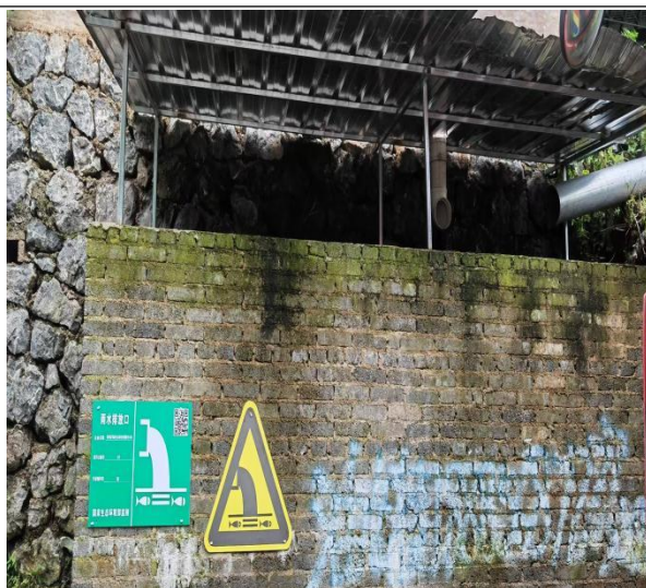
初期雨水收集池
