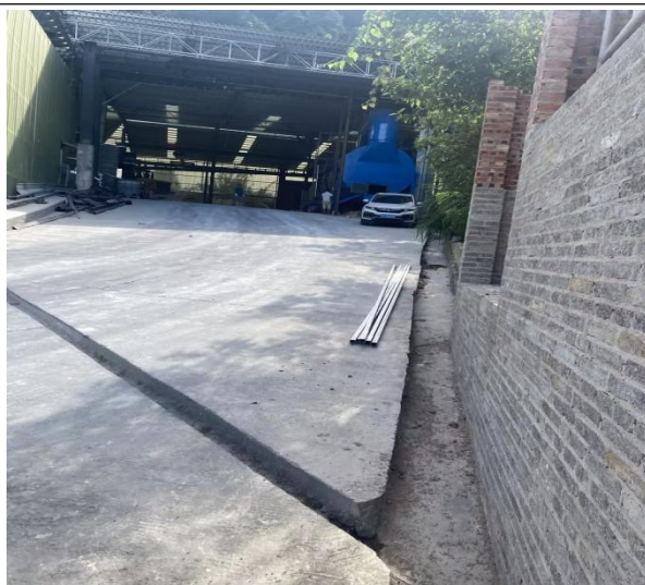
厂区雨水导排水沟
