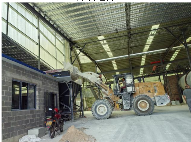
1#生产线进料口+三面密封式厂房
