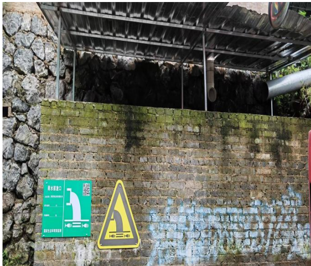
初期雨水收集池
