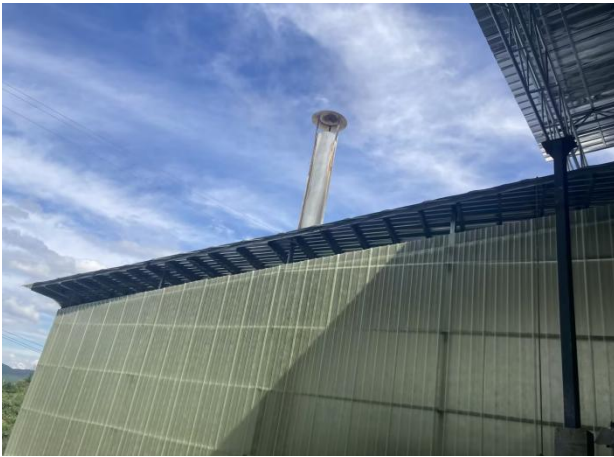
1#生产线排气筒（DA001）
