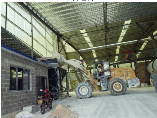
1#生产线进料口+三面密封式厂房
