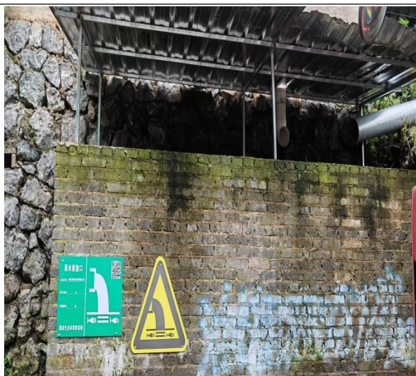
初期雨水收集沉淀池
