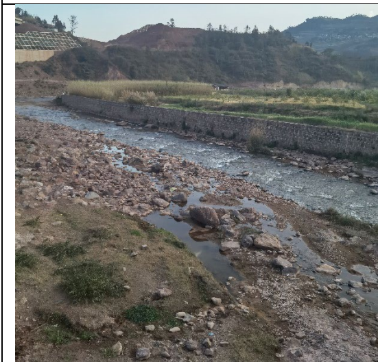
银江河三期工程及河堤复绿现状
