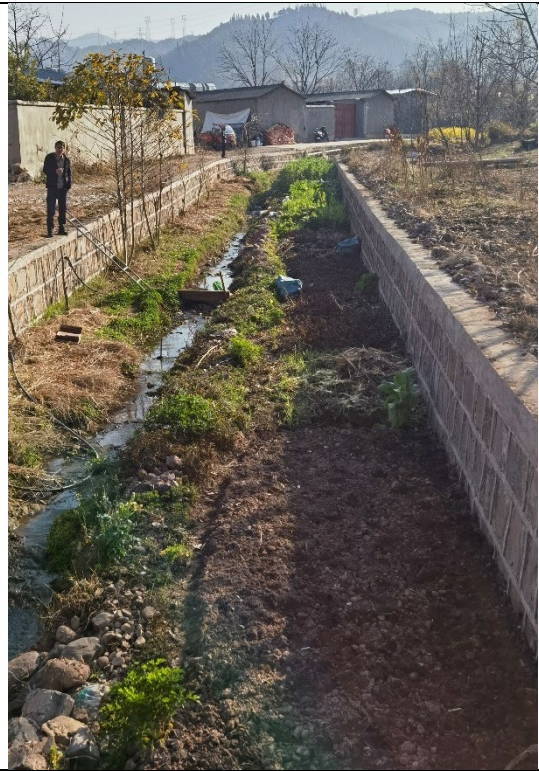
摇头河治理工程及河堤复绿现状
