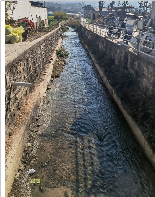
卓潘河治理工程（左侧河堤）现状
