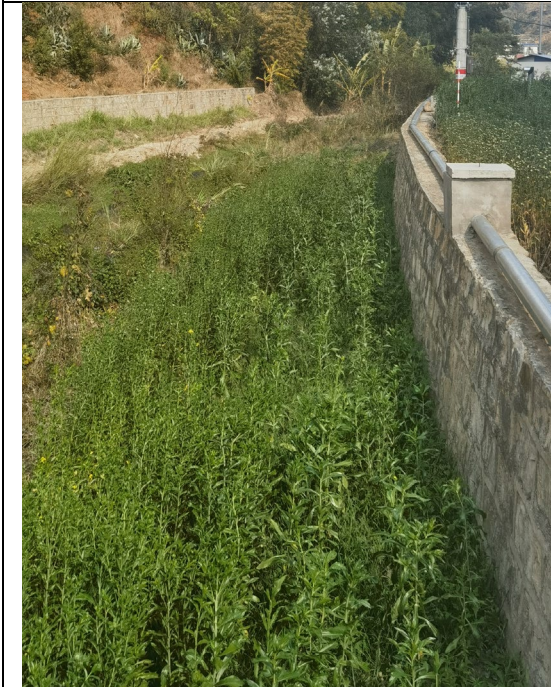
倒流河二期工程及河堤复绿现状
