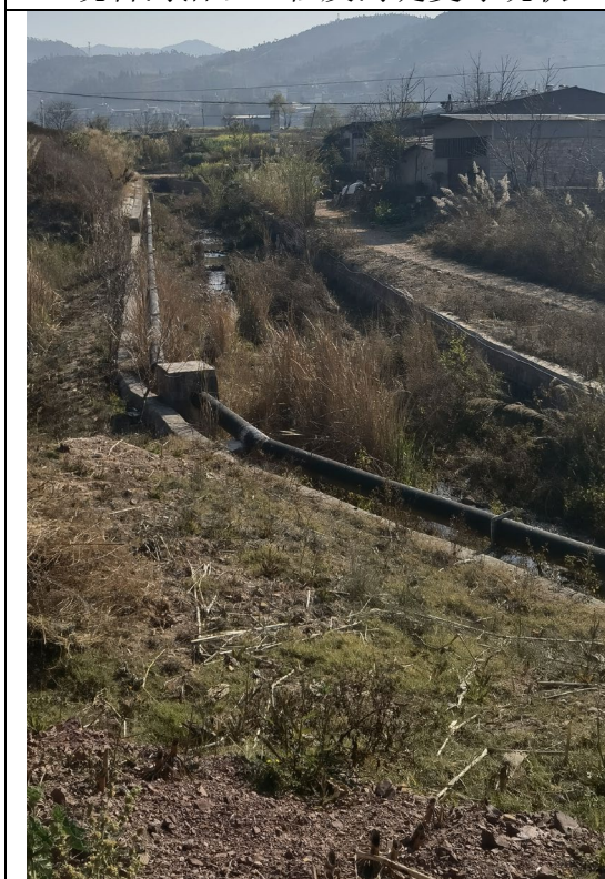
中屯河治理工程及河堤复绿现状
