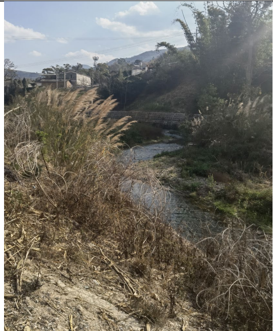
倒流河二期工程及河堤复绿现状
