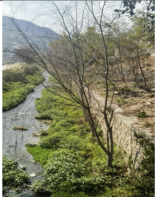
倒流河二期工程及河堤复绿现状
