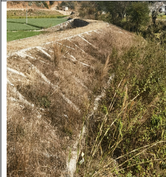
河堤护坡及临时道路复绿
