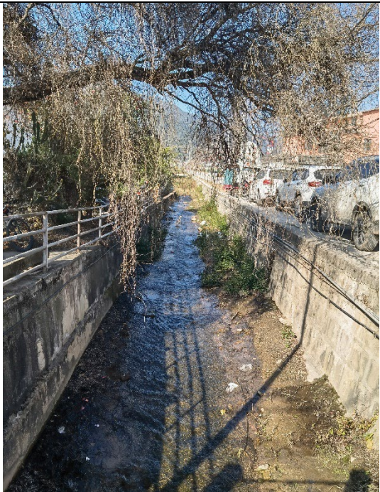
卓潘河治理工程（左侧河堤）现状
