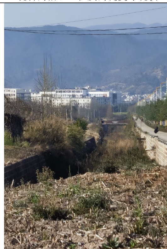
中屯河治理工程（左堤）现状
