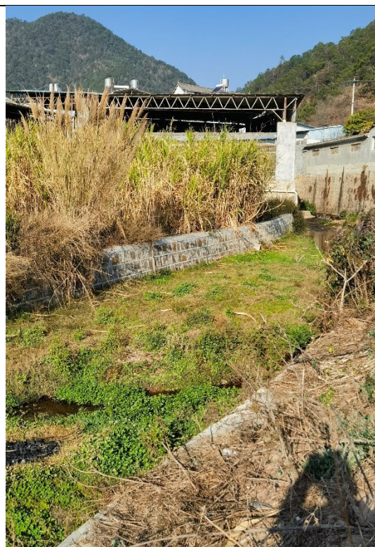
新河治理工程现状
