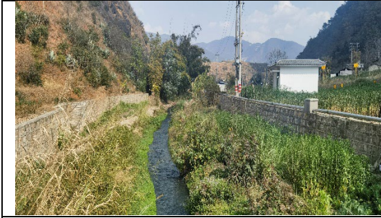
倒流河二期工程及河堤复绿现状
