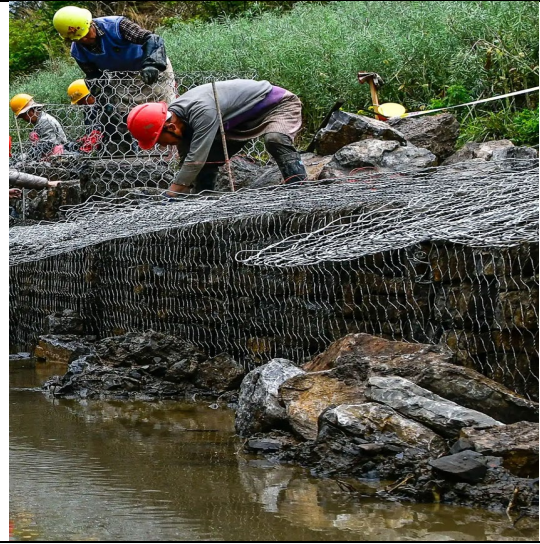
格宾笼施工照片
