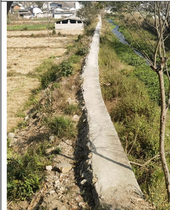
倒流河二期工程及河堤复绿现状
