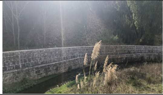
倒流河二期工程及河堤复绿现状
