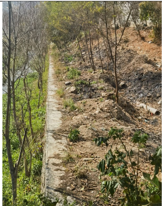
倒流河二期工程及河堤复绿现状
