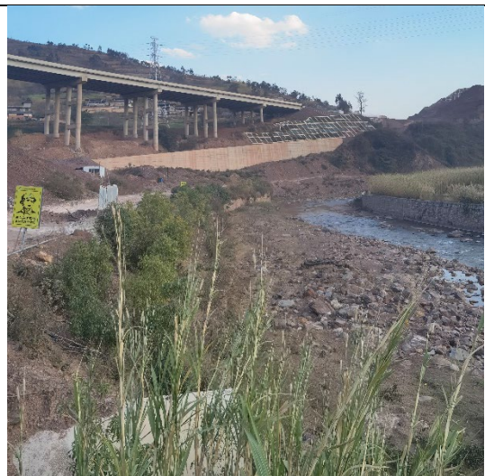
银江河三期工程及河堤复绿现状
