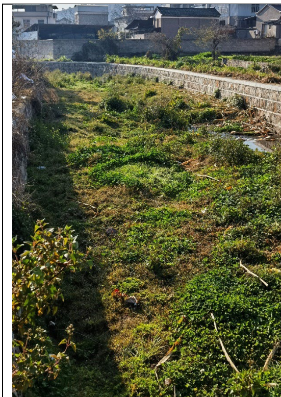
新河治理工程现状
