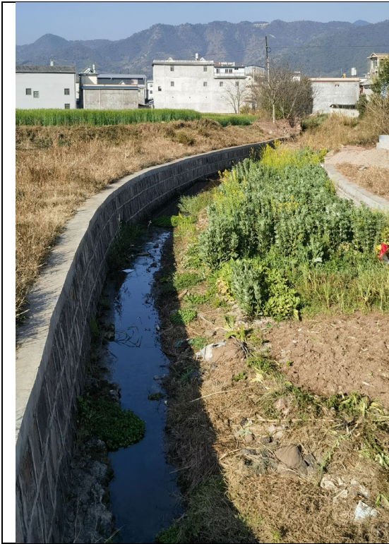
摇头河治理工程及河堤复绿现状
