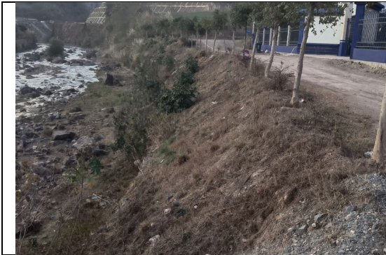
银江河三期工程及河堤复绿现状
