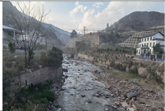
银江河三期工程及河堤复绿现状
