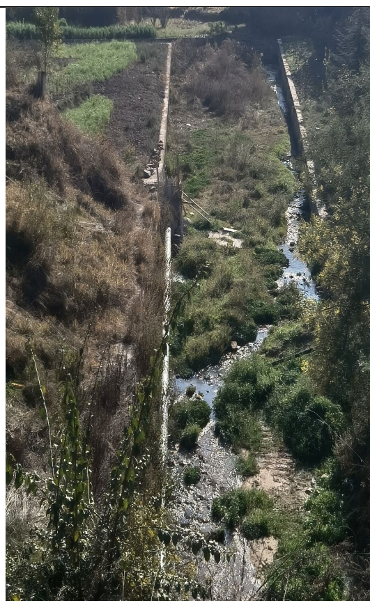
观音河治理工程及河堤复绿现状
