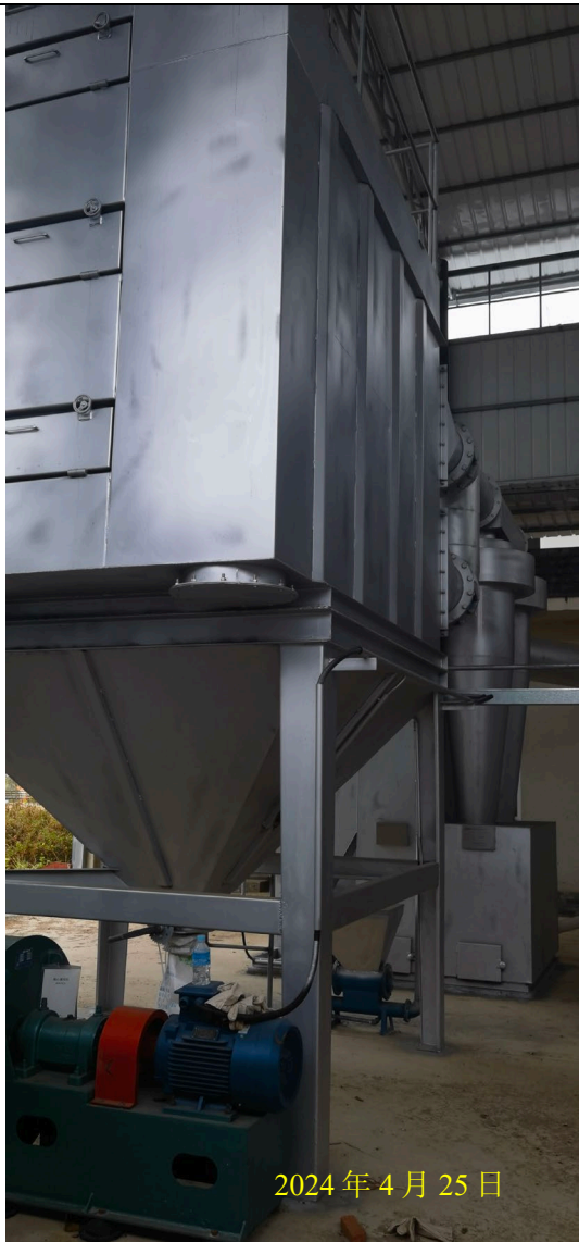
遗物焚烧炉废气处理设施
