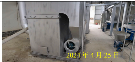
废气处理系统活性炭吸附装置
