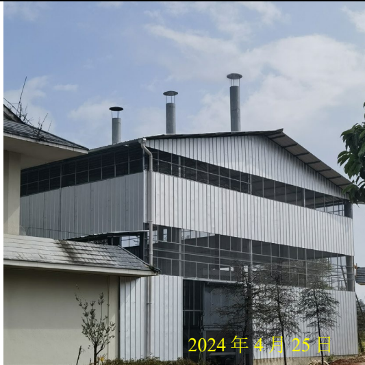
火化、遗物焚烧废气排气筒
