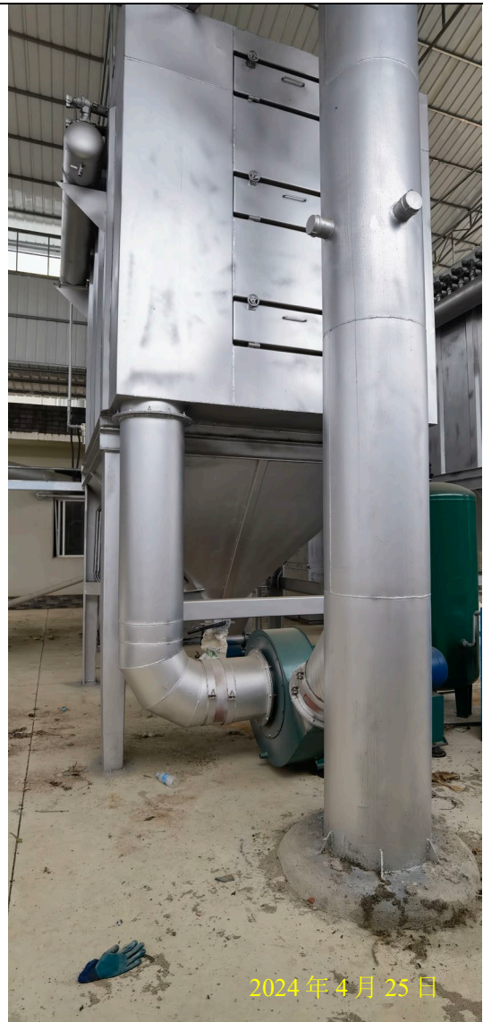
火化废气处理设施及监测口
