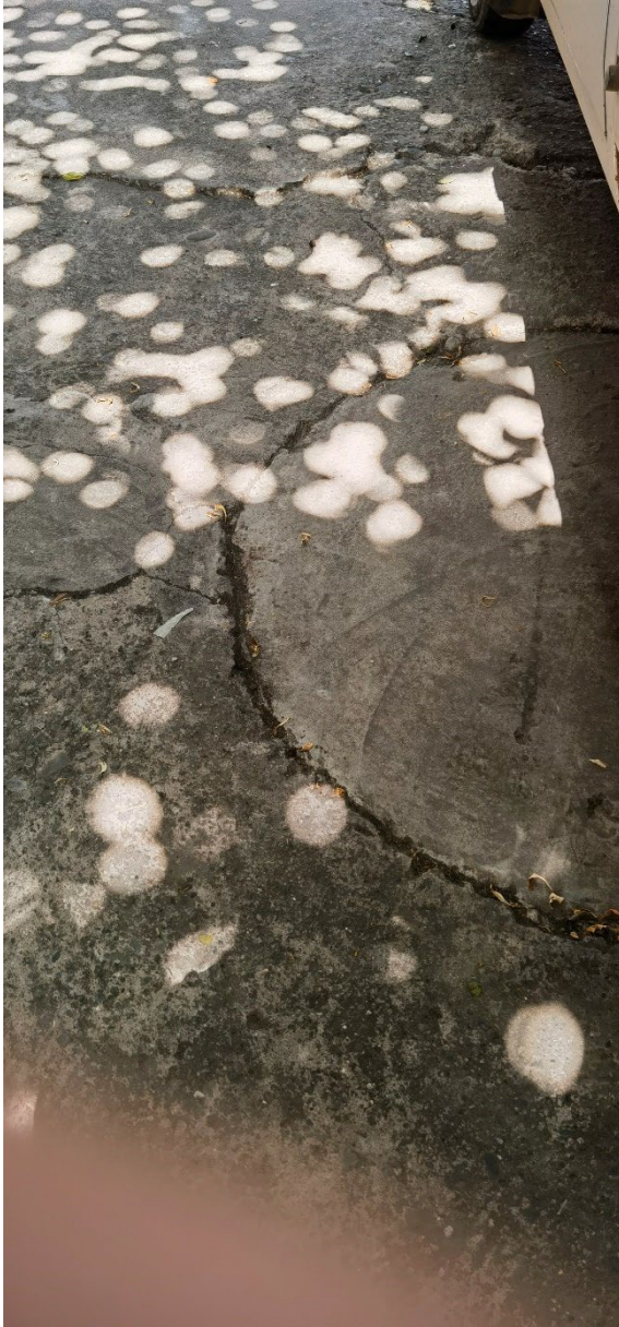
办公生活区化粪池
