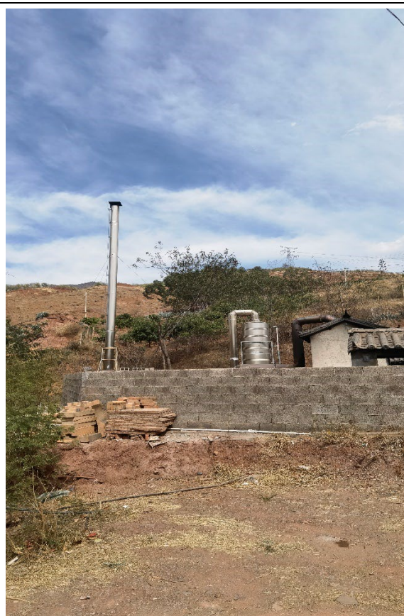
遗物焚烧炉水膜除尘装置及排气筒
