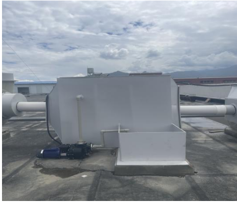
无机废气碱性喷淋系统
